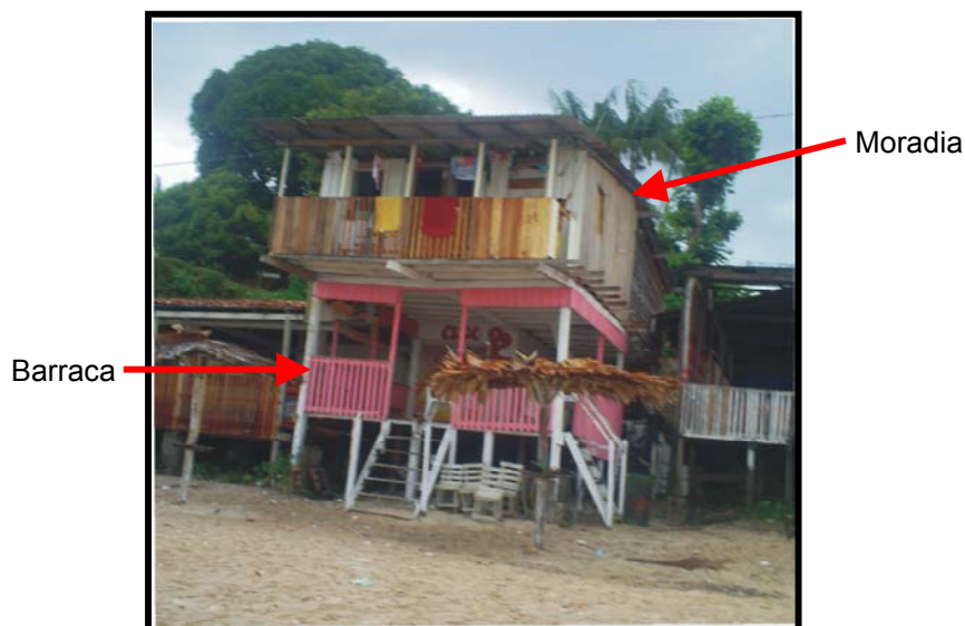
Figura 25 - Modelo construtivo das barracas na praia de Vila do Conde. Acervo fotográfico: Rodrigues e Verbicaro, 2007.
